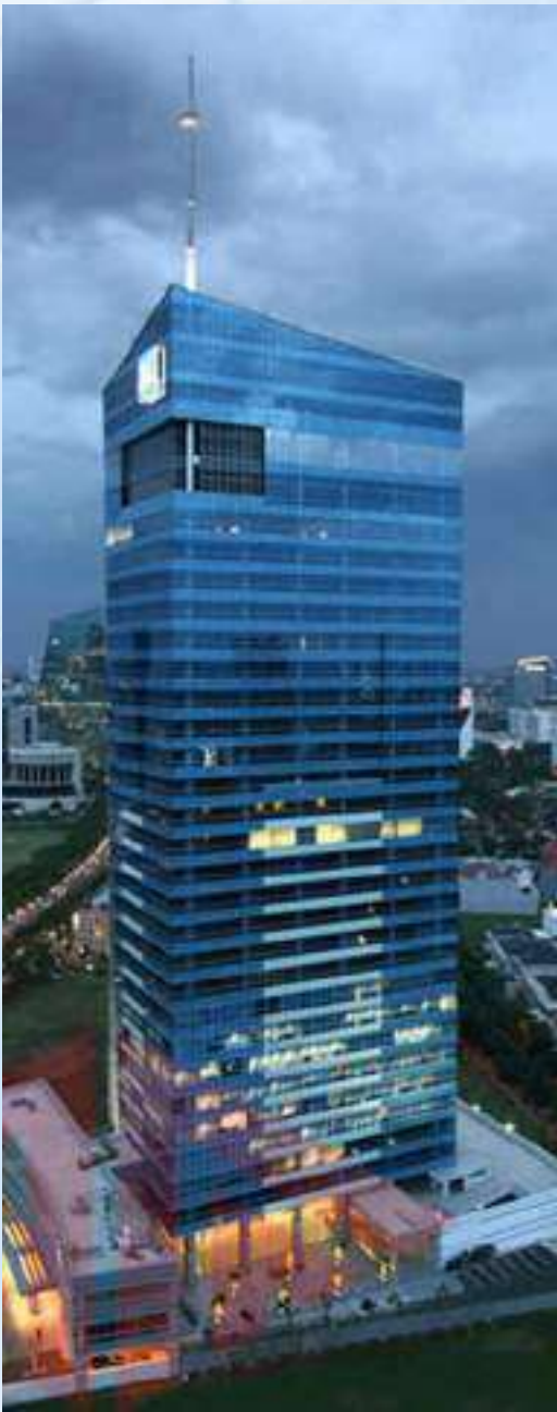
Menara Prima - Mega Kuningan 3 X 1300 KVA
