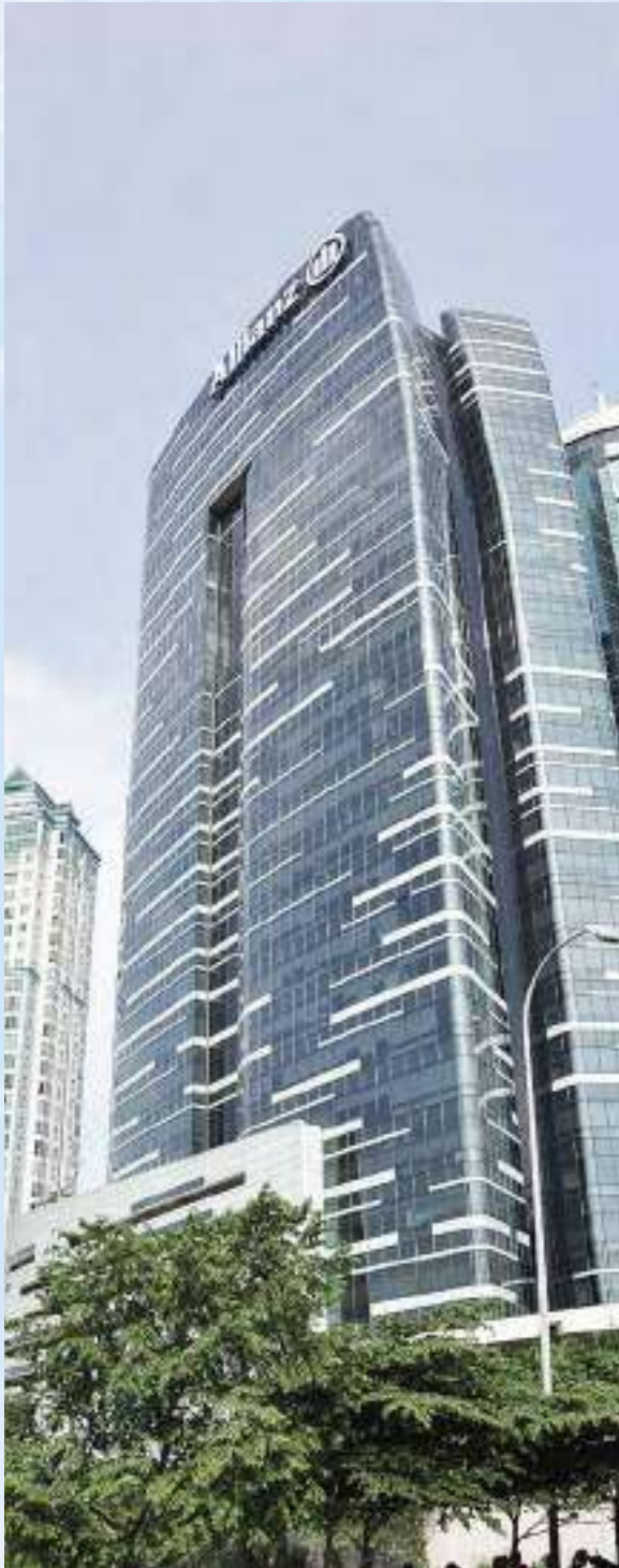
Allianz Tower - Kuningan 3 X 1125 KVA
