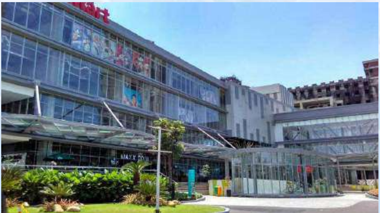
Marvell City Surabaya 2 x 1362,5 KVA, 2 x 1450 KVA, 3 x 1800 KVA
