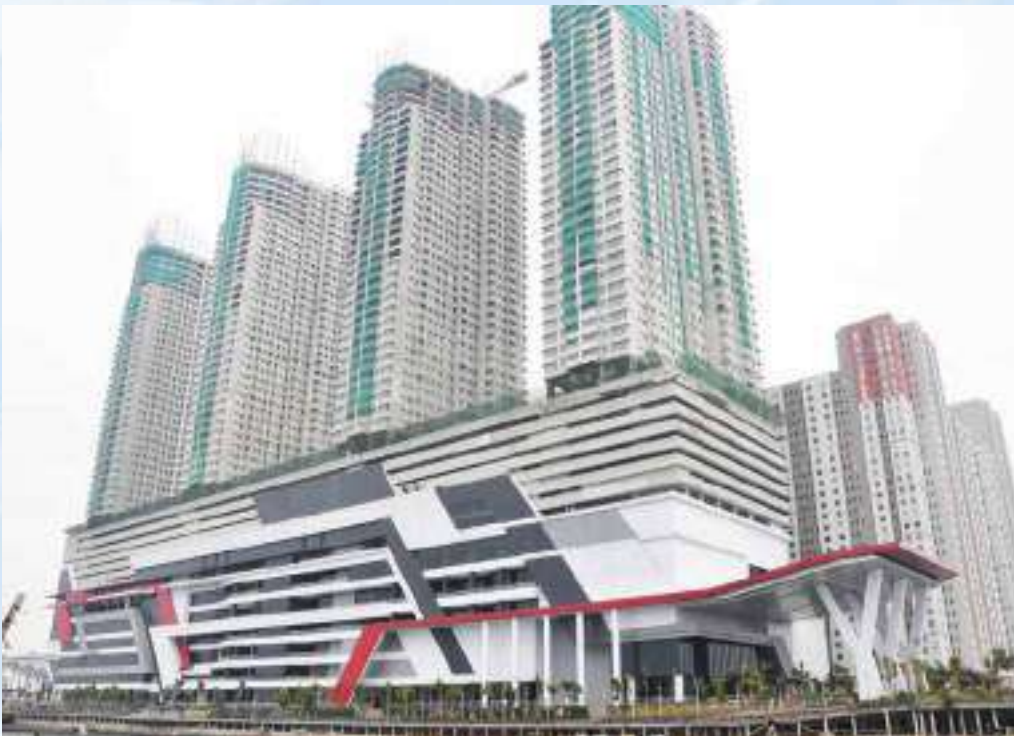
Green Bay Pluit Tahap II Mall, Hotel & Condominium 5 X 2000 KVA, 1 X 1125 KVA, 3 X 1600 KVA
