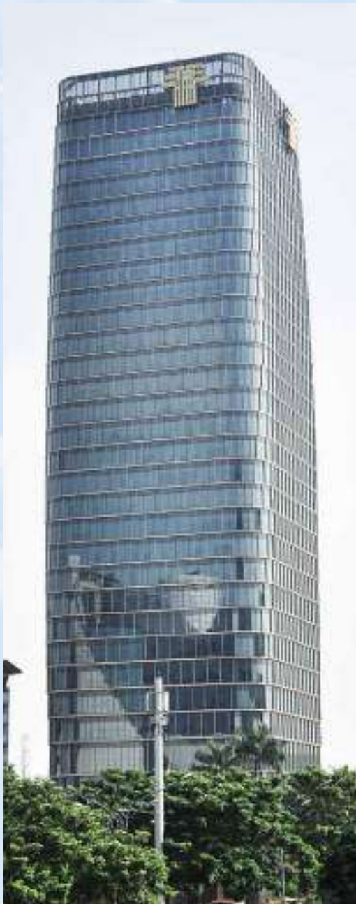
Tempo Scan Tower 3 X 2030 KVA
