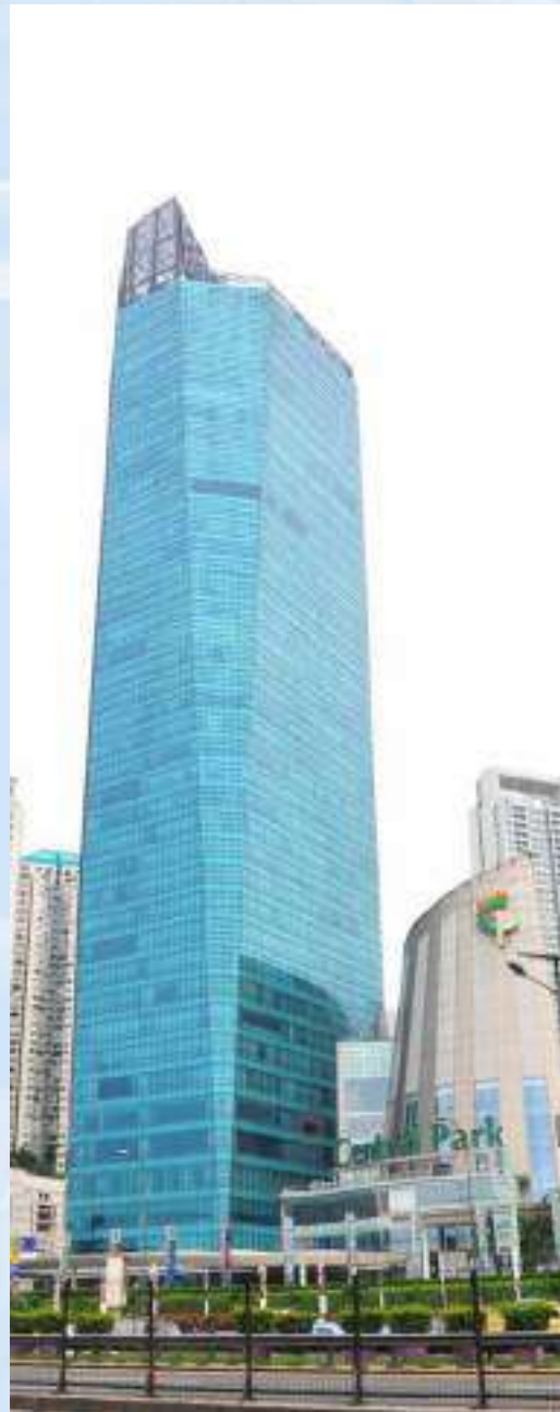
Central Park Mall & Soho - Podomoro City 2 X 1800 KVA, 2 X 1125 KVA, 7 X 2000 KVA
