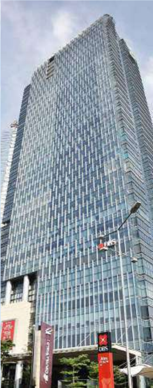
Ciputra World 14 X 2030 KVA, 2 X 1362 KVA
