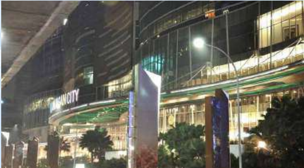
Kuningan city - 6 x 1800 KVA, 6 x 2030 KVA, 1 x 680 KVA
